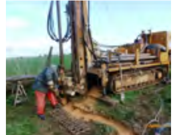
Le forage des piézomètres atteint une profondeur de près de 90 mètres où se situe la nappe souterraine.
