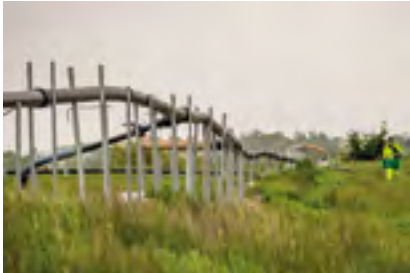
Les réseaux de collecte du biogaz ont été rehaussés pour éviter la formation de condensats. Leur contrôle est hebdomadaire.
