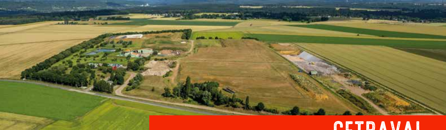
Vue aérienne du Cetraval
