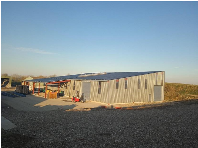
Bâtiment de l'unité de déconditionnement, muni d'une couverture photovoltaïque
